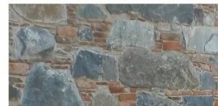
Εξωτερική τοιχοποιία από τοπική σιδηρόπετρα με χαλίκωμα από άλλους μικρούς οπτόπλινθους και τσιμεντοκονίαμα.
