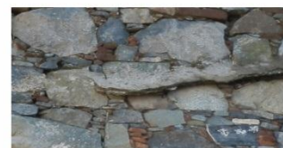
Εσωτερική τοιχοποιία από τοπική σιδηρόπετρα με χαλίκωμα από άλλους μικρούς οπτόπλινθους χωρίς τσιμεντοκονίαμα.
