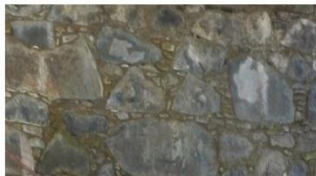
Εξωτερική τοιχοποιία χολιασμένη με άλλους μικρούς πλίνθους.
