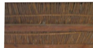
Οροφή από βολίτζια - καλάμια - φτερίτζια - χώμα - χωλετρωτά κεραμίδια.
